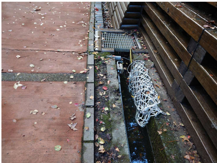
矩形排水溝架設棉繩攀爬網
