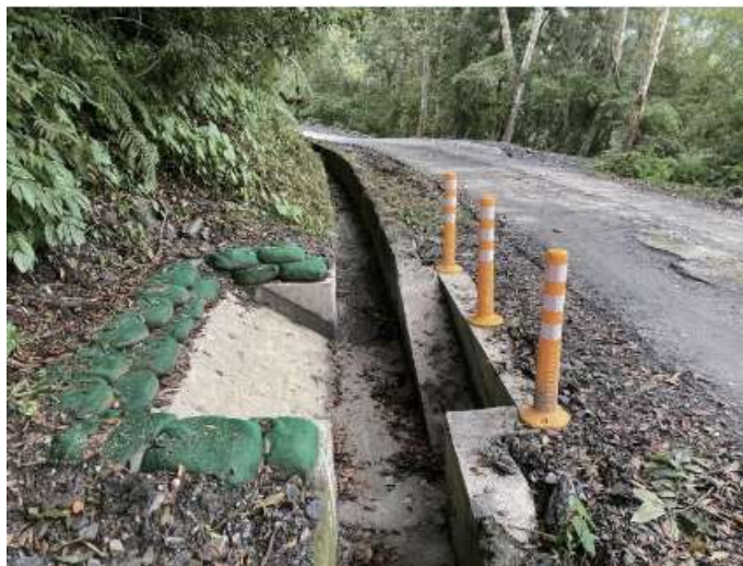
設置內側垂直道路，而外側平行道路方向的混凝土斜坡道
