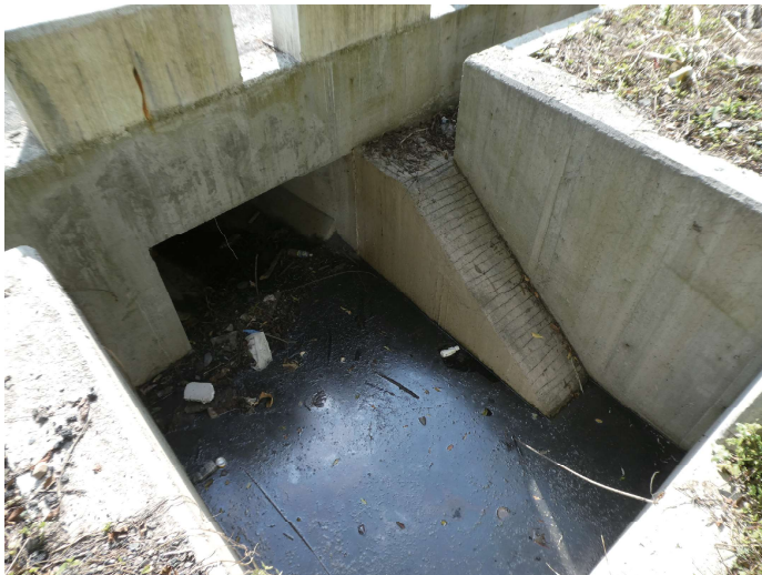
混凝土斜坡道
