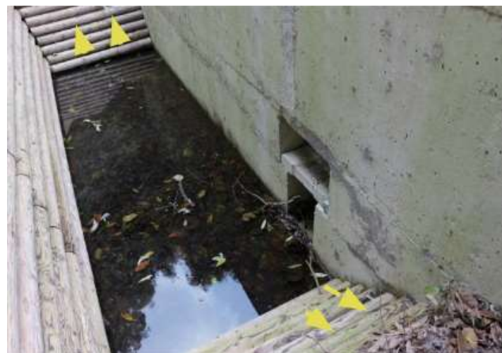
混凝土斜坡道，表面鋪設木材
