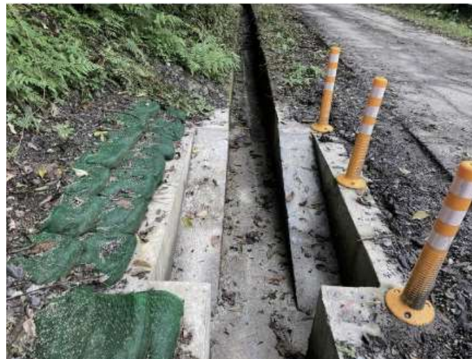
設置兩側平行道路方向的混凝土斜坡道
